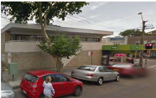
TAB, Borrodale Rd
